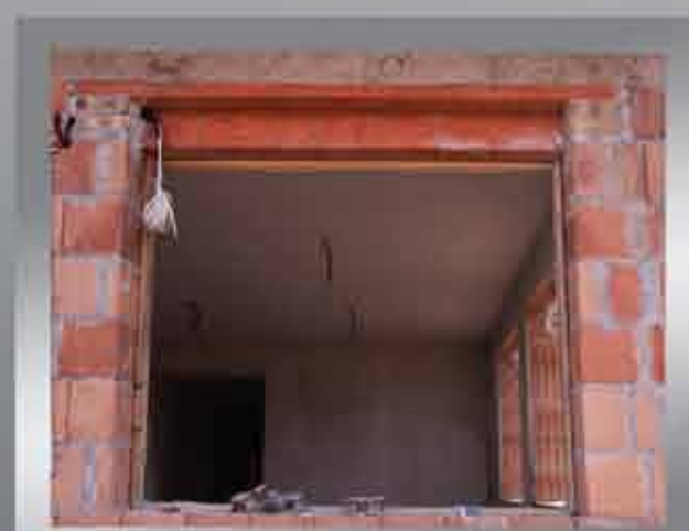
1. Lépcsős áthidaló szakszerű beépítése
